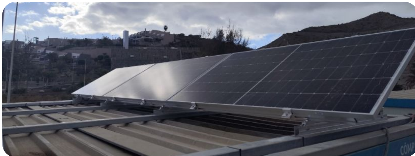
Estructura plug-in con placas fotovoltaicas, obra de urbanización en Balito | Gran Canaria
