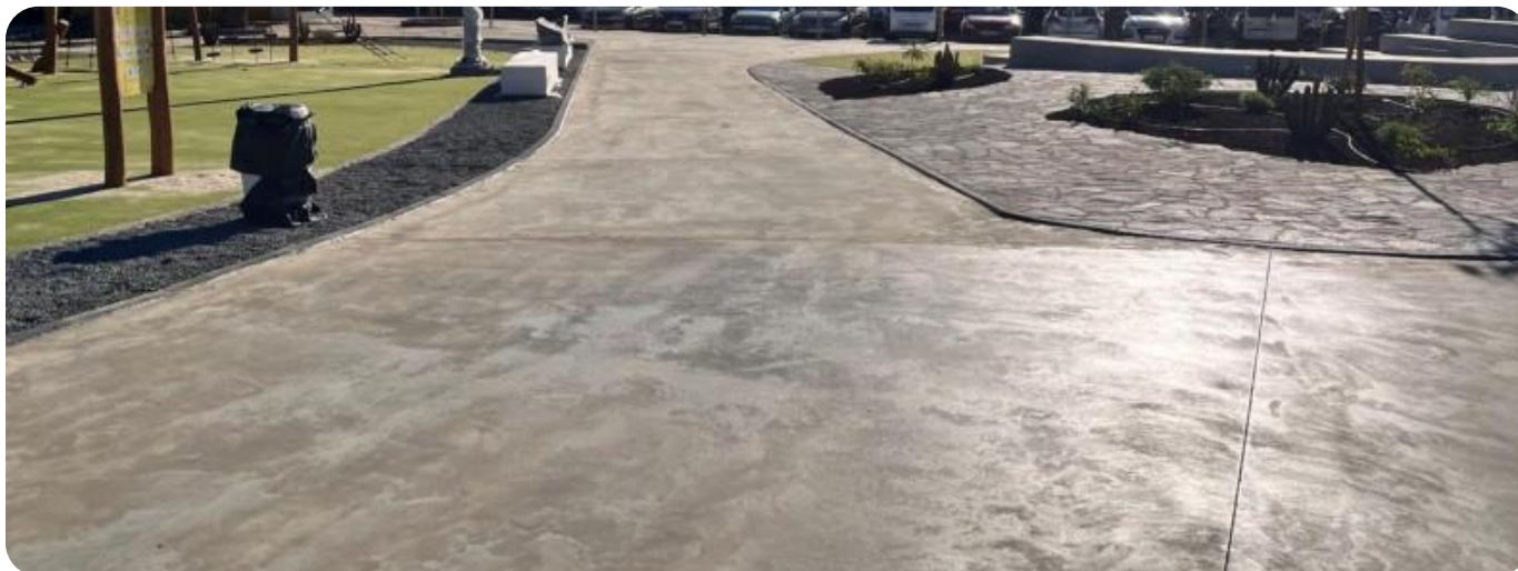
Pavimento con vidrio reciclado, Parque La Paredilla, Vecindario, Gran Canaria
